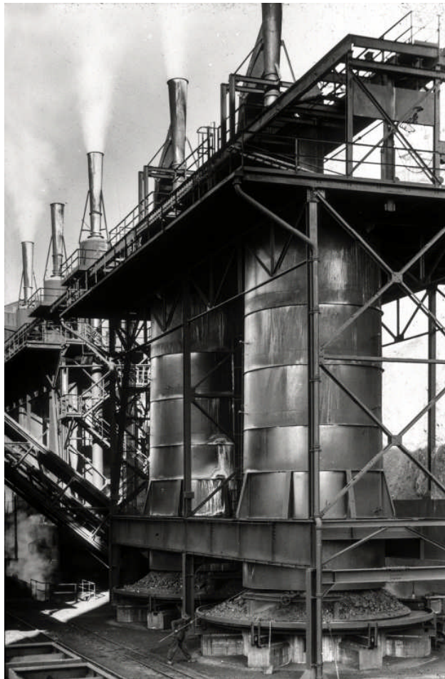
Abb. 8 Batterie von Hochleistungsröstöfen, wie sie auch auf Füsseberg standen (hier die der Verbundanlage San Fernando-Wolf gegenüber im Sottersbachtal)
