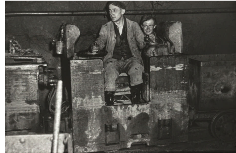
Abb. 5 Akku-Tenderlok in der Gangstreckenförderung der 50er Jahre
